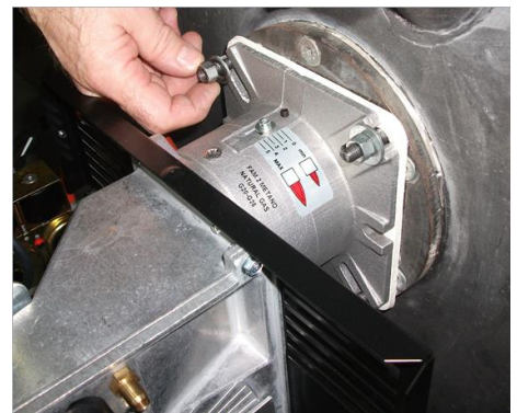
6 - Зафиксировать горелки на котел;
