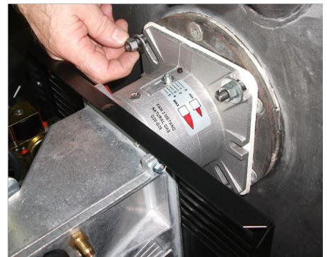
6 - Зафиксировать горелки на котел;
