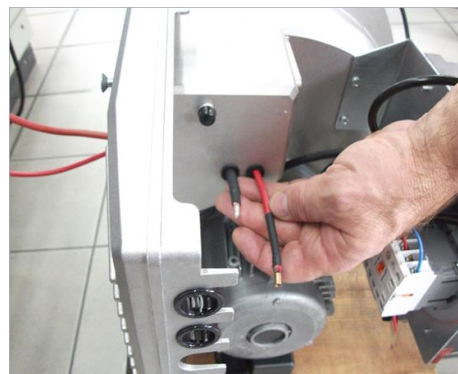
12 - пропустив кабель электрода поджига и кабель электрода ионизации через отверстие;
