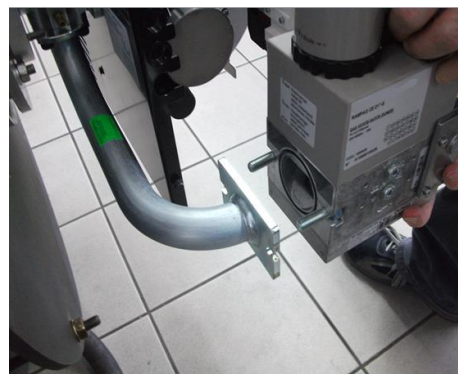
9 - установить электроклапан на Труба ГАЗОВОЙ рампы;
