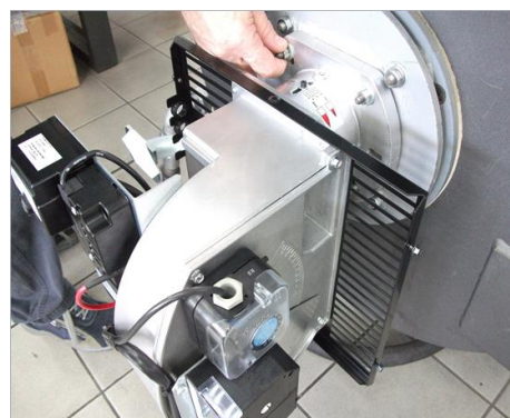
6 - Зафиксировать горелки на котел;
