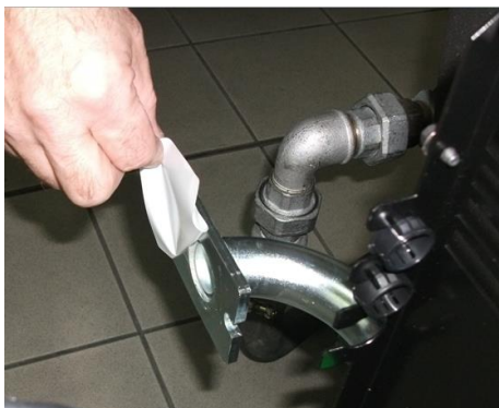
7 - Снять заглушку из Труба ГАЗОВОЙ рампы;
